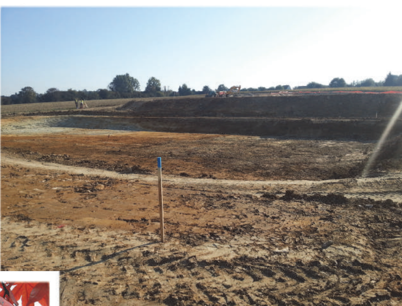
Terrassement de lagune à la station d'épuration
